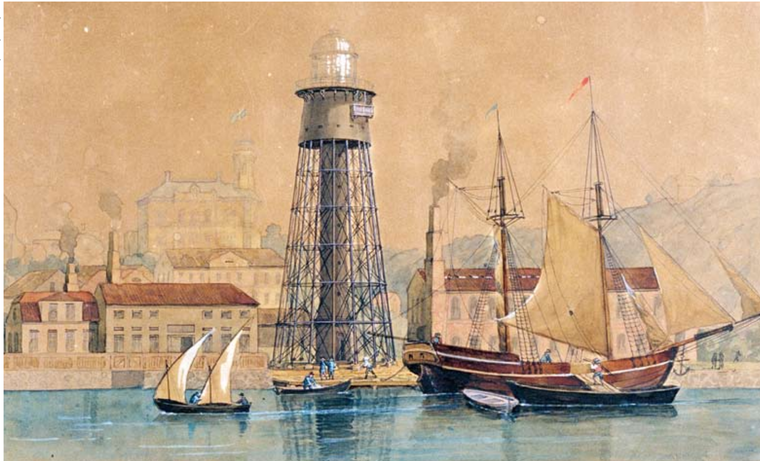
Heidenstamfyrarna provmonterades innan utskeppning. Bilden från Ludvigsborgs mekaniska verkstad på Söder Mälarstrand i Stockholm visar Kapelluddens fyr eller Pater Noster.
