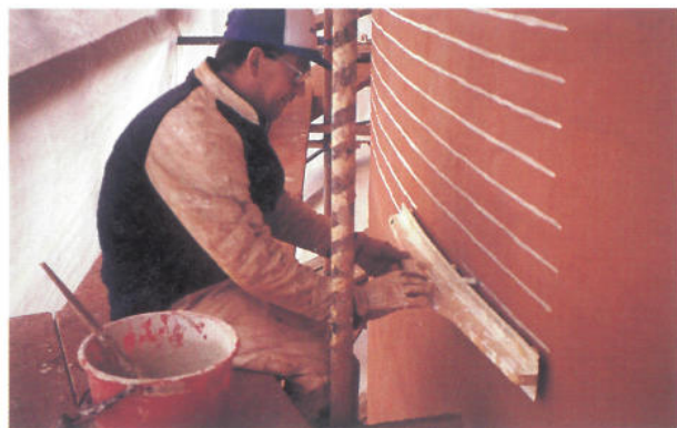
De målade tegelfogarna har på traditionellt vis dragits med pensel utefter en ritbräda.
