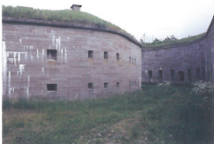
I vallgraven finns s k kaponjärer, byggnader från vilka vallgraven kan beskjutas. Graven har en böjd form så att man inte av misstag skall beskjuta den andra kaponjären.
