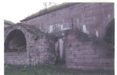
På bilden syns en trappa upp efter escarpmuren. Den var tänkt att användas vid anfall. Men lika väl kunde fienden smyga ner denna väg. Därför togs vilplanet mitt på trappan bort och när fienden i mörkret smög ner föll han handlöst till marken. Trappan kallas av militären för en "Haha".
