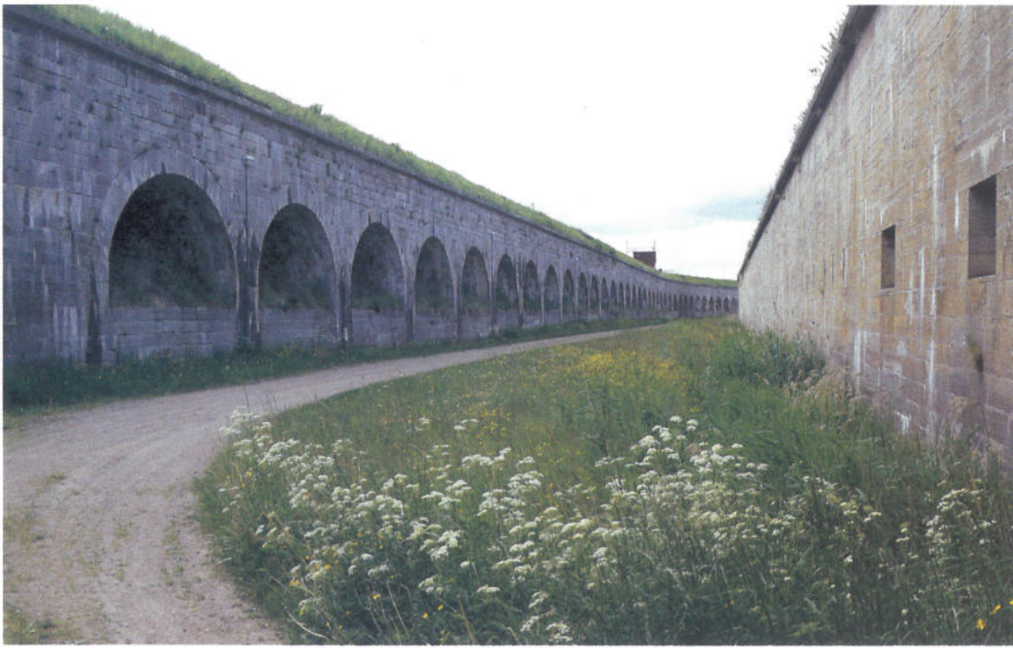
Vallgravens yttre beklädda väggar kallas escarpmur och de motstående, in mot fästningen kallas contrescarpmur.
