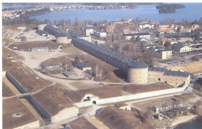
Längst ner till vänster syns vallgraven, bakom den en sammanhängande jordtäckta byggnad. I mitten av bilden syns slutvärnet, med dess karaktäristiska två tornbyggnader. På sin tid var det Europas längsta byggnad, med sina nära 680 meter.
