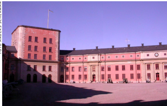
Tornet och norra delen av Östra linjen. Fasadskador på tornet är i akut behov av åtgärder, putsnedfall med risk för personskador finns. Östra linjens plåttak i behov av åtgärder inom de närmaste fem åren.
