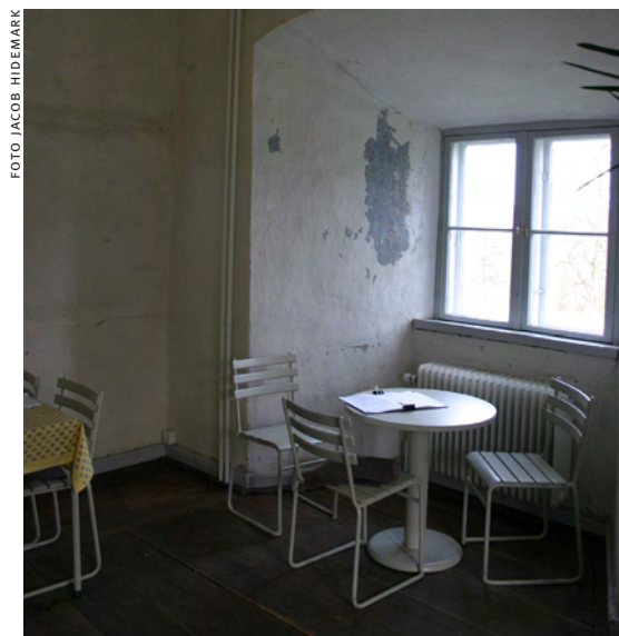
Exempel på Borgens slitna interiör. I detta rum på första våningen behöver tidigare utförda lagningar med bruk bättringsmålas med kalkfärg.
