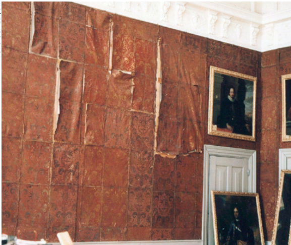
Salsta slott: Gyllenlädertapeterna från sent 1600-tal är unika. Lädret har krympt och spruckit på grund av det olämpliga inomhusklimatet.
