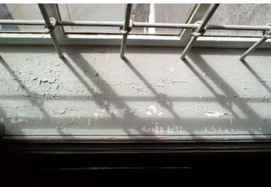
Drottningholms slott: Flagnande linoljefärg i fönsternisch på Drottningholms slottsteater.
