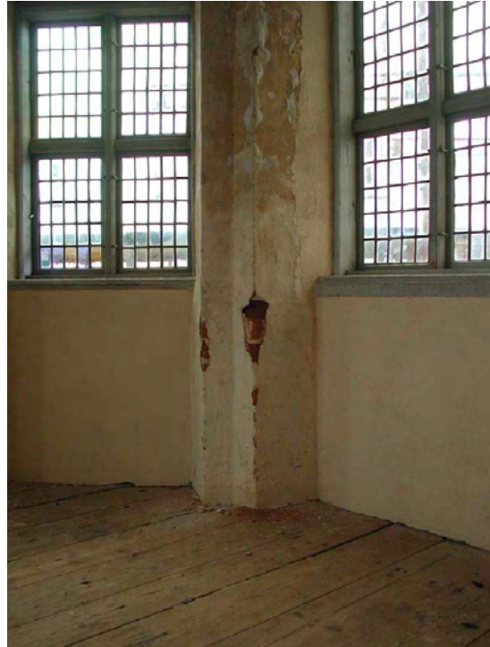
Läckö slott: Interiört resulterar putsskadorna i saltutfällning och frostsprängning.
