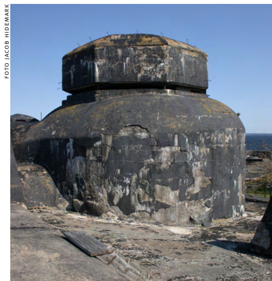
Behovet av att täta överyrtorna t är stort, här visas ett exempel från Linje 3.
