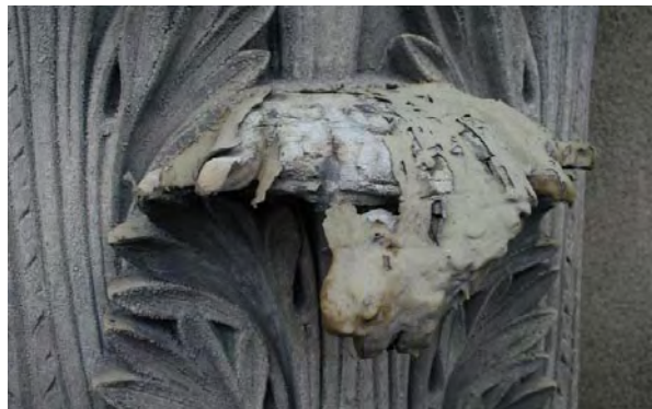
Skadat akantusblad på ett korintiskt kapital. Samtliga horisontella partier spacklades med härdplast tidigt 1970-tal.
