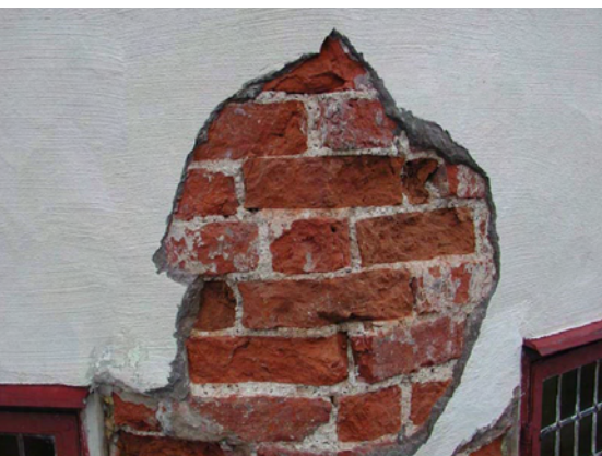
Läckö slott: Frostsprängd puts med spjälkad tegelsten på hörntorn i sydöst.
