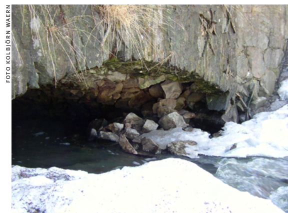
Ulriksdals slott: Nedrasade stenar i murvalv i bron över Igelbäcken.
