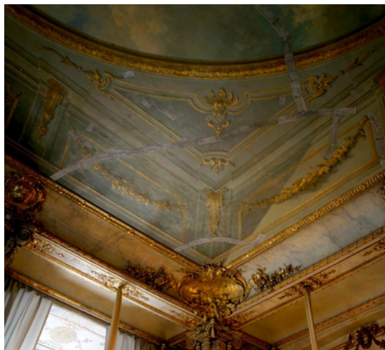
Stockholms slott: Provisorisk förstärkning i takets plafondmålning i Pelarsalen.
