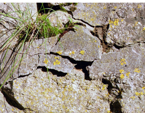
Kalmar slott: Ravelinens gråstensmurar blev omfogade 1973. Äldre fogbruk bilades bort och ett hårt och tätt cementbruk påfördes med sprutmunstycke. De nya cementfogarna kan inte följa murverkets rörelser, fogarna spricker och frostsador uppstår. Bakomliggande kalkmurbruk löses upp och förlorar sin sammanhållning.
