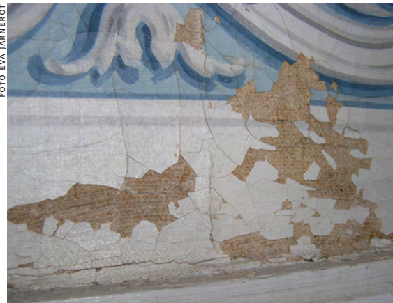
Salsta slott: Interiörmåleriet på Salsta är av mycket hög klass men de far idag mycket illa. Här spjälkar sig dekormåleriet på väggen i det främsta empire-rummet.
