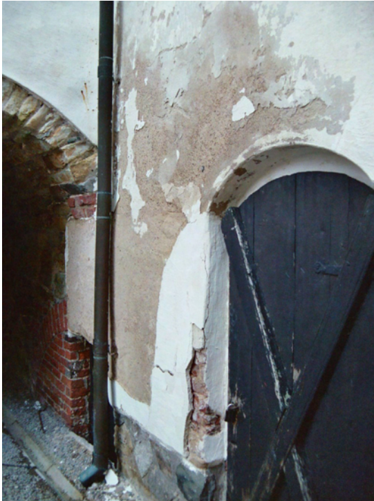
Läckö slott: Exteriöra skador i den putsade fasaden.
