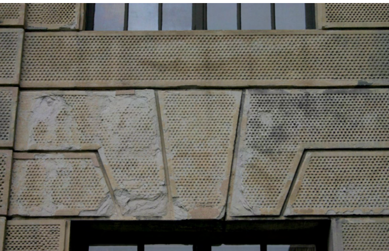
Stockholms slott: Skador i den mönsterhuggna sandstensfasaden på nordvästra flygeln. Sandstenen skiktat sig i olika lager och faller ner med risk för personskadorna.
