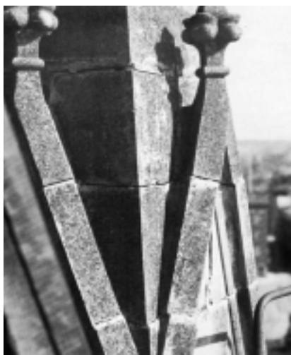
Vid Helgo Zettervalls restaurering av Uppsala domkyrka byttes större delen av murteglet ut mot nytt och listverk och ornament nyttillverkades i cement.
