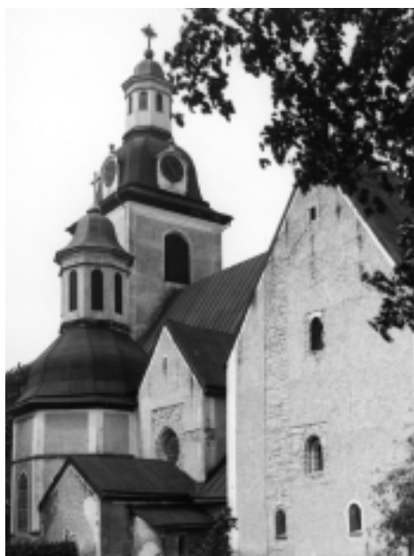
Sigurd Curmans fotodokumentation av förundersökningen 1907. Murverket framträder tydligt under putsavknackningarna.
