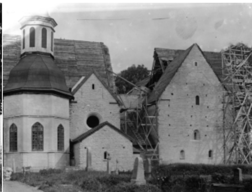
Rivningen av taket 1915.
