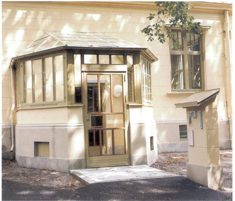
Det gamla växthuset vid södra gaveln har blivit entré för rullstolsbundna, härifrån nås en nyinstallerad hiss.
