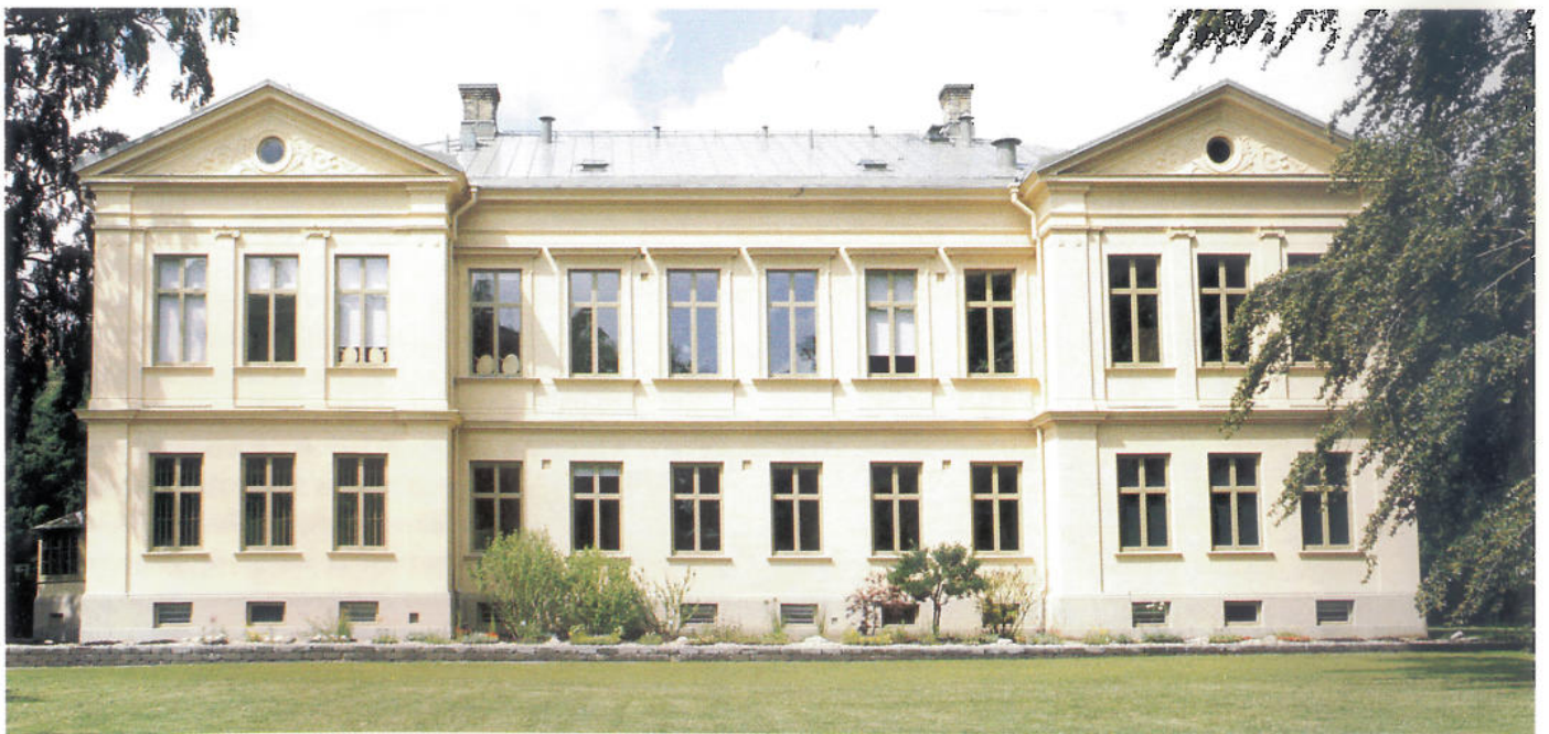
Den östra fasaden vetter mot Botaniska trädgården. Fasaderna är nyrenoverade och har återfått sin ursprungliga färgsättning så Vita villan gör inte längre skäl för namnet.
