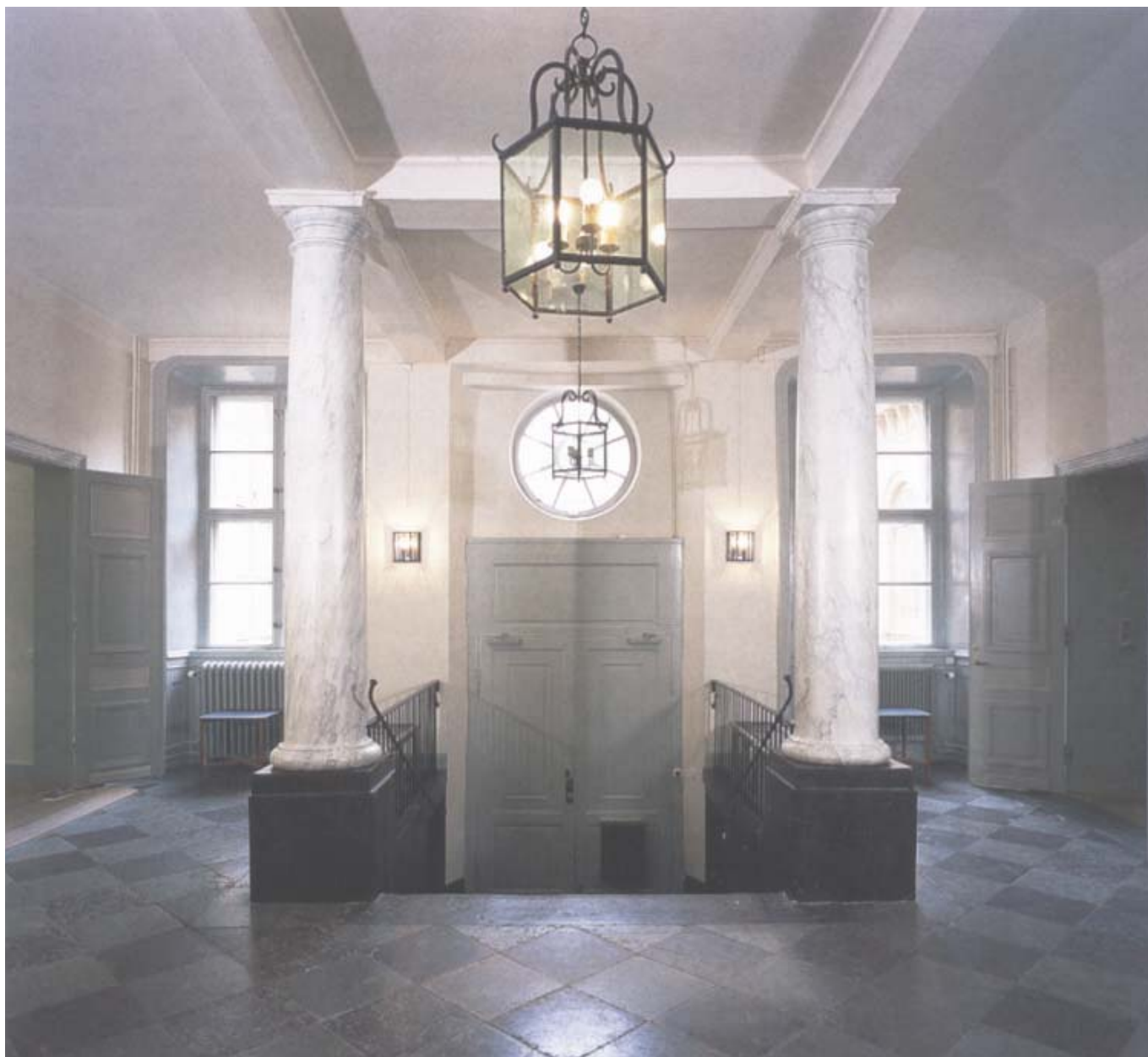
I samband med flyglarnas tillkomst byggdes yttertrappan om så att den fick ett kortare och rakt lopp mot porten. Porten placerades något lägre och trappan fick fortsätta en bit in i entréhallen.
