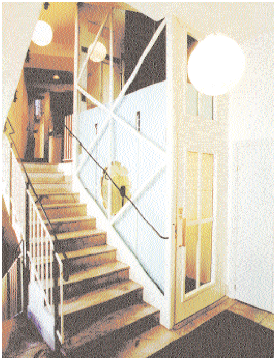
En ovanligt vacker lösning på den sedvanliga kollisionen mellan gammal arkitektur och moderna arbetsmiljökrav.
