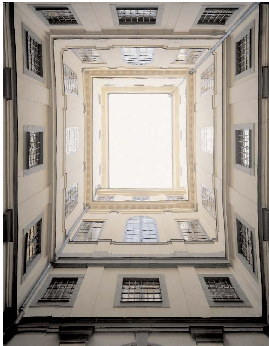
Västra gården. Tessin d.y. har på litet utrymme skapat en romersk miljö med hjälp av fasadartikulering. På en hög sockel står doriska pilastrar, över dessa en smal gesims och en mezzaninvåning indelad med lisener; sedan ytterligare en gesims med en hög attika från vilken de joniska pilastrarna reser sig i huvudvåningen. För att få bättre proportioner på gården har den översta våningen inga pilastrar, utan dessa avslutas våningen nedanför med en arkitrav och en kraftig konsolgesims.
