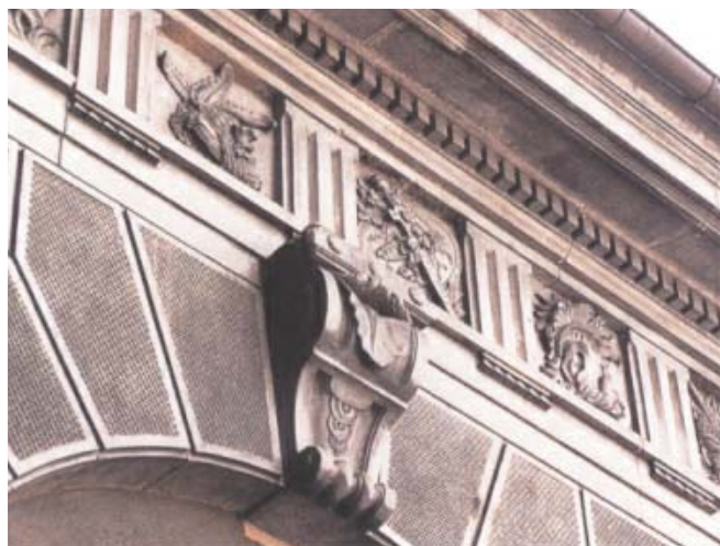
Den gotländska sandstenen kan bearbetas till ytterst fina detaljer. Metopfris och fjällhuggning på kommendantsflygel.
