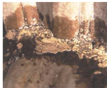
Rester av oljefärg på sten i ett skyddat hörn.
