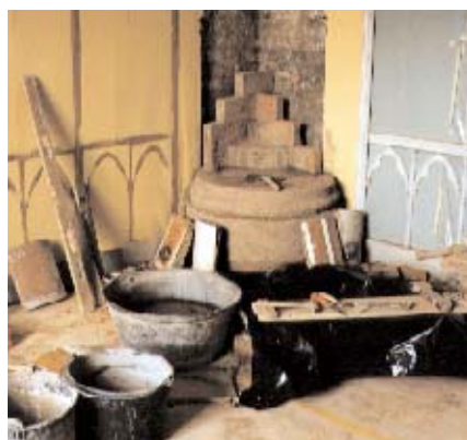
Den götiska kakelugnen muras åter upp i Götiska rummet på Stockholms slott.
