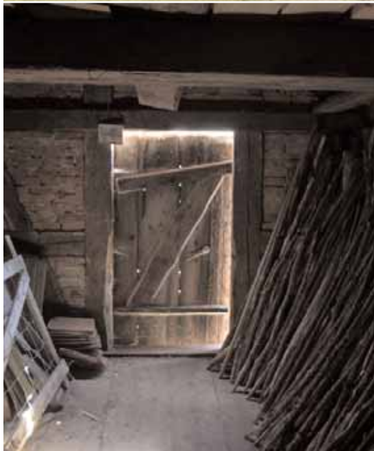
Kungsladorna eller Ryssladorna vid Visingsborgs kungsgård uppfördes på 1730-talet. Enligt traditionen skulle de ha byggts av ryska krigsfångar.
