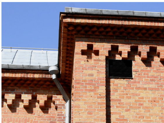
Takföt med tandsnittslister
